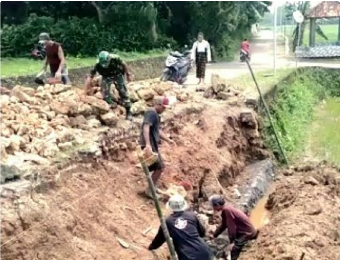
Karya Bakti pembuatan plengsengan penahan jalan
