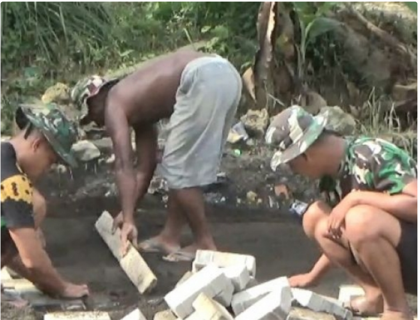
Tim Satgas TMMD Reguler ke-113 Kodim 0829/Bangkalan terus bekerja menyelesaikan pemasangan Paving di Masjid Desa Gangseyan
